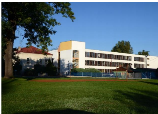
Areál budov Do Nového
