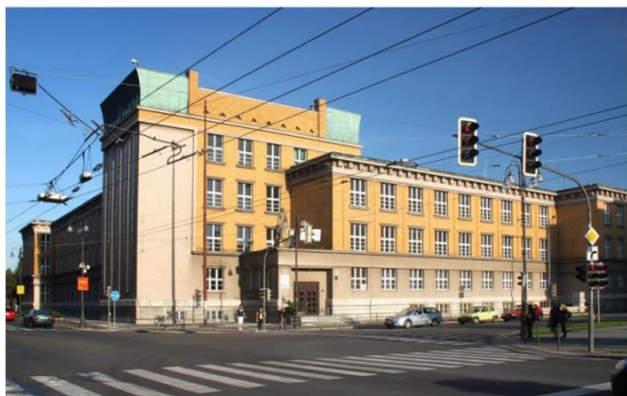
Hlavní budova školy Karla IV.
